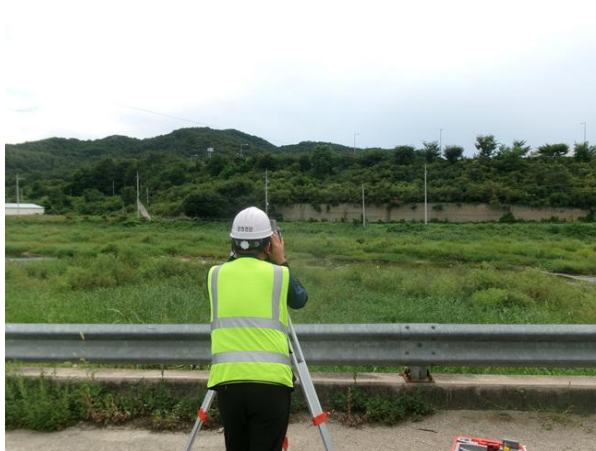
광파기를 이용한 측량 작업
