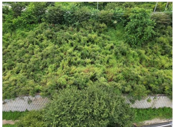
상부 성토부 전경
